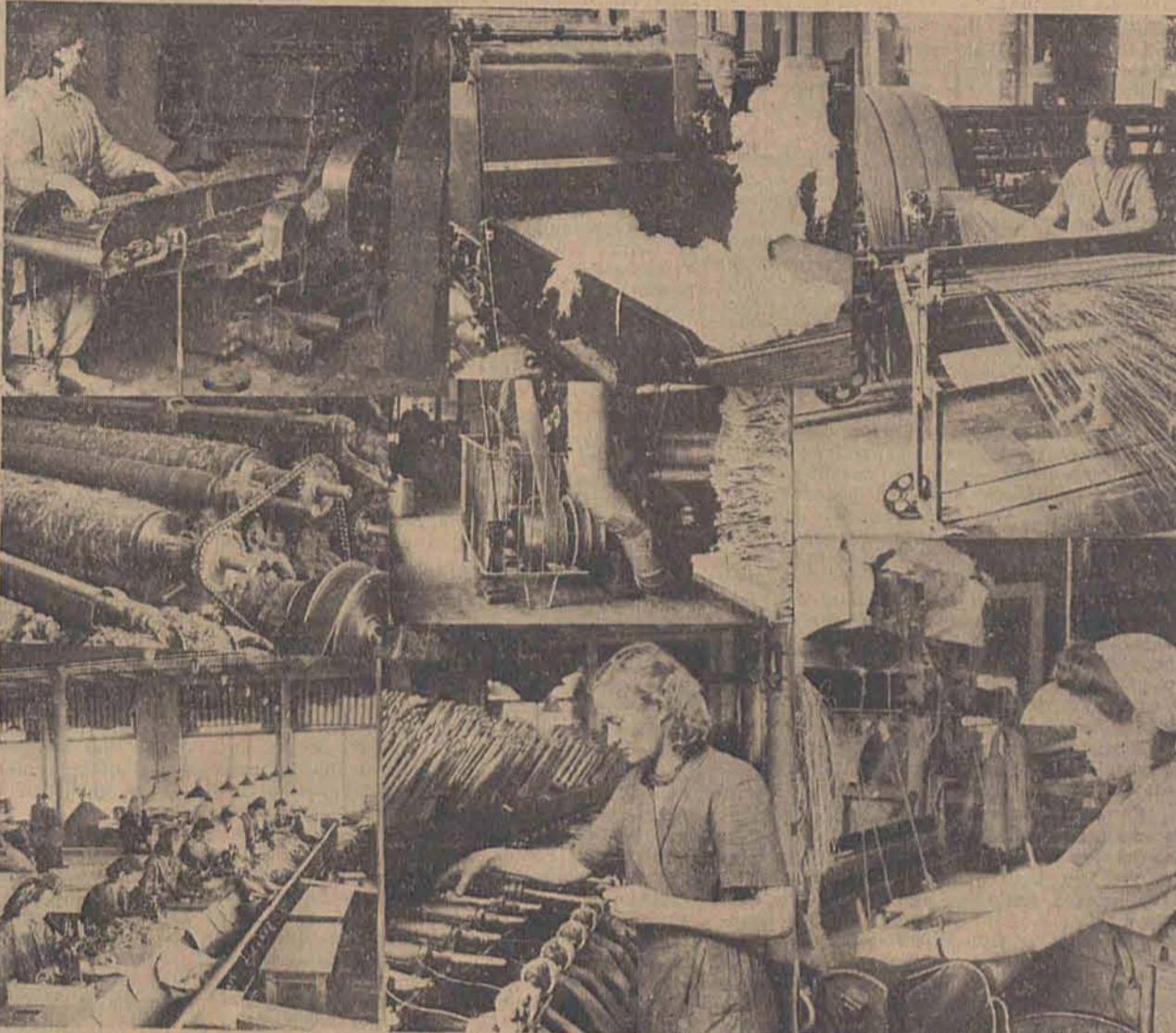
Obere Reihe: Links: Der Lumpenreißer, der zur Auflösung von Altstoffen in wieder verwertbaren Spinnstoffen dient. Mitte: Auflösung des gepreßten Rohstoffes im „Ballenbrecher“. Rechts: Die Konus-Scheermaschine, die die in der Kettstrichtung laufenden Fäden auf eine größere Warenbreite vorbereitet. Mittlere Reihe: links: Im „Tuchkrempe“ wird das Fasergut aufgelöst. Mitte: Die Gewebereinigungsmaschine arbeitet mit dem Absaugverfahren und säubert das Gewebe. Untere Reihe: links: Auch „Sacknäherer“ ist wichtig. Mitte: Abspaltung der getrockneten Garnstränge auf der Schußspinnmaschine. Rechts: Arbeit am Webstuhl. (Atlantia, Hans Pusek [8])
