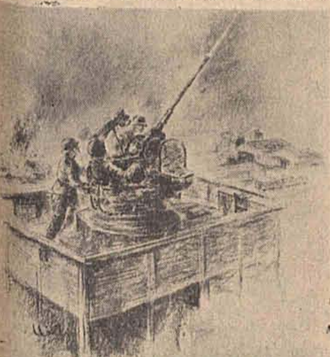
Leuchte Flak bei der Abwehr von Luftangriffen
