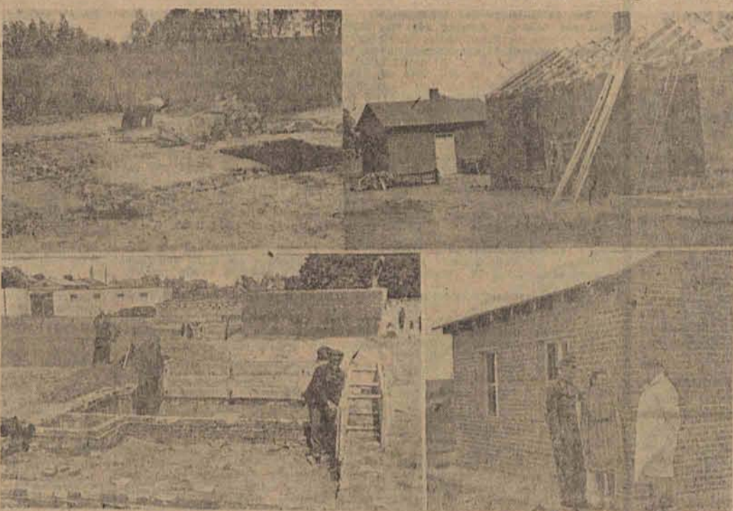
Von oben nach unten — links: Die Ausschachtungsarbeiten zu der Schierater Behelfsheimfiedlung sind beendet und der Schotter zum Fundament wird eingestampft. Die ersten Erhebungen wachsen in der Stampflehbauweise aus dem Boden. — Rechts: Bald ist wieder ein Behelfsheim-Doppelhaus unter Dach gebracht. Glückstrahlend unterhalten sich die ersten Behelfsheimbewohner mit dem Bürgermeister. (Aufn. [8]: Donnerlein)
