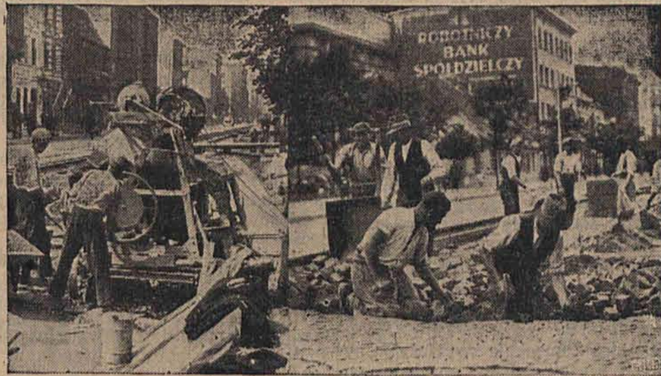
Na ulicy Piotrkowskiej układana jest nowoczesna nawierzchnia z szlachetnego materiału — kostki bazaltowej na podkładzie betonowym. Na zdjęciu z lewej widzimy pracę betonarki, z prawej — układanie kostki bazaltowej.
