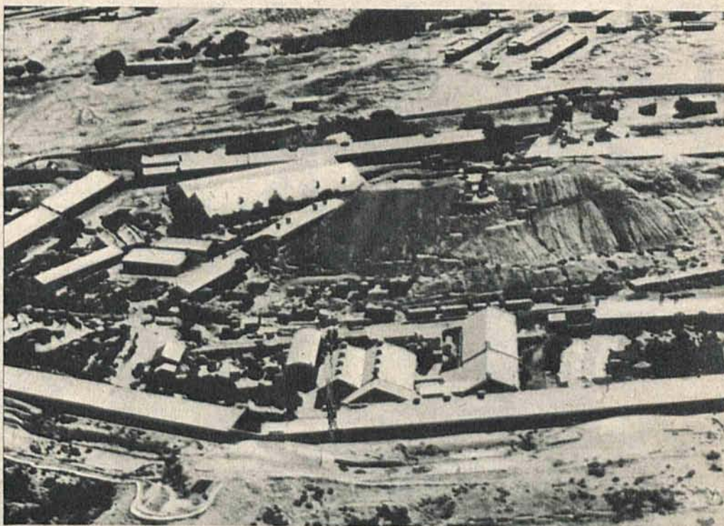
Widok miasta Quetta w Beludżystanie, które zostało zniszczone katastrofalnym trzęsieniem ziemi.
