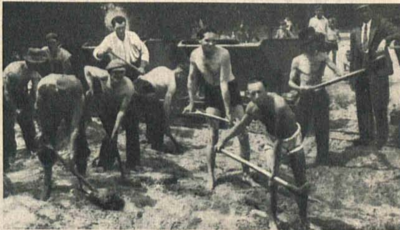
Rozpoczęcie sezonu robót publicznych. Zdjęcie przedstawia bezrobotnych Łodzi zatrudnionych przy robotach publicznych na terenie zamiejscowym.
