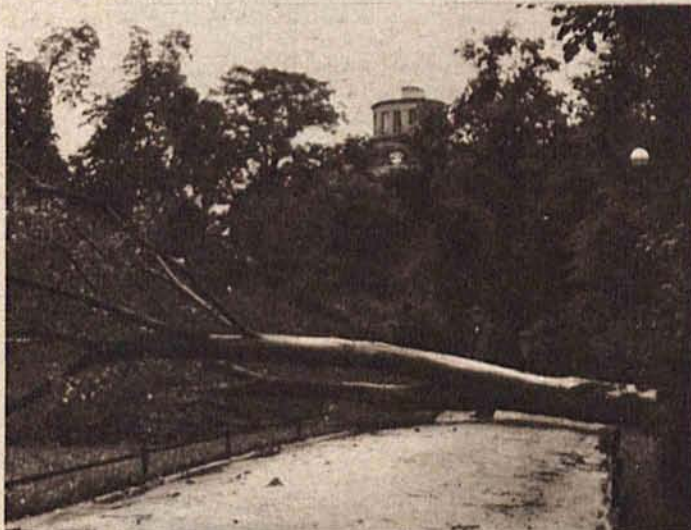
Zniszczenie przed Poczta Główną.
