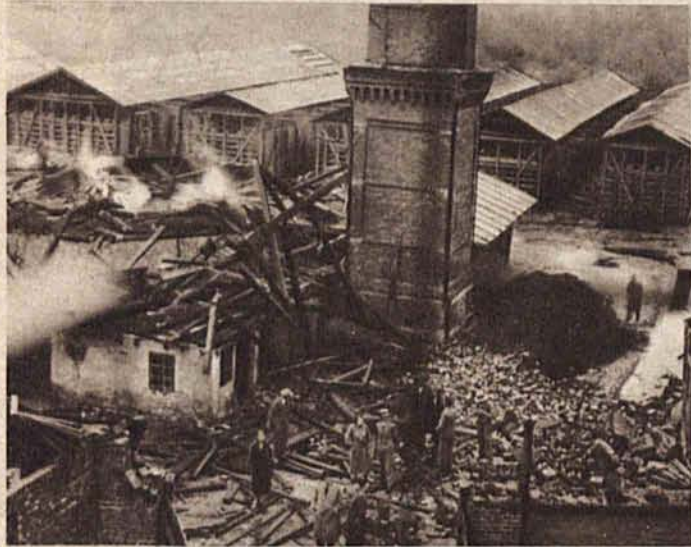
Zrujnowana cegielnia w Łąkiwnikach.
