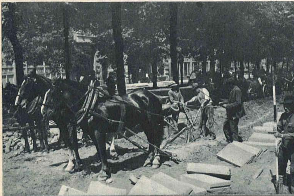
Orka na ulicy łódzkiej: przebudowa jezdni na Al. Kościuszki
