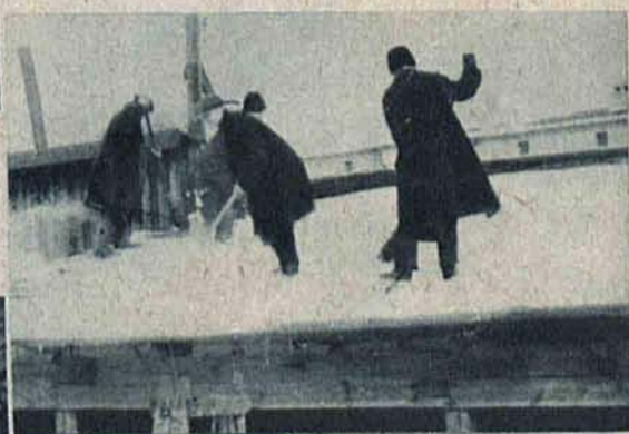
Bezrobotni zatrudnieni przy usuwaniu śniegu z dachu budynku państwowego.
