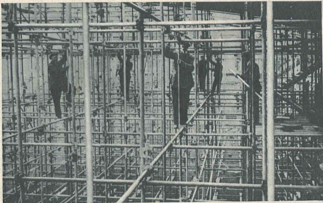
Budowa prowizorycznej trybuny na 12.000 osób w Greenwich. Na zdjęciu widoczny szkielet z stalowych rur.
