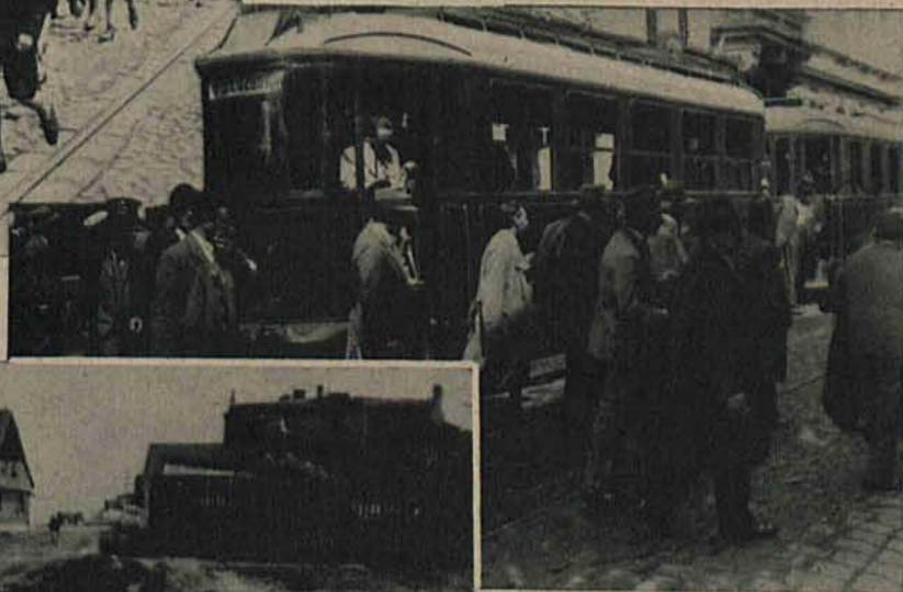
Specjalne pociągi tramwajowe przewożą elektryków czechosłowackich przybyłych na zjazd.
