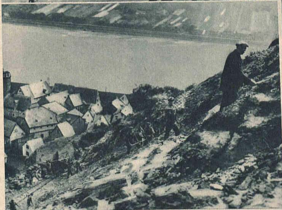
Burzenie góry koło Lorch nad Renem grożącej obsunięciem się na domki miasteczka.
