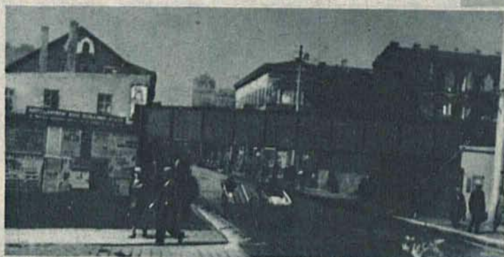
Most kolejowy na ul. Kilińskiego już jest rozbierany całkowicie. Wkrótce przez ulicę tę przejeżdżać będzie tramwaj, a place kolejowe zostaną zamienione na piękne skwery.
