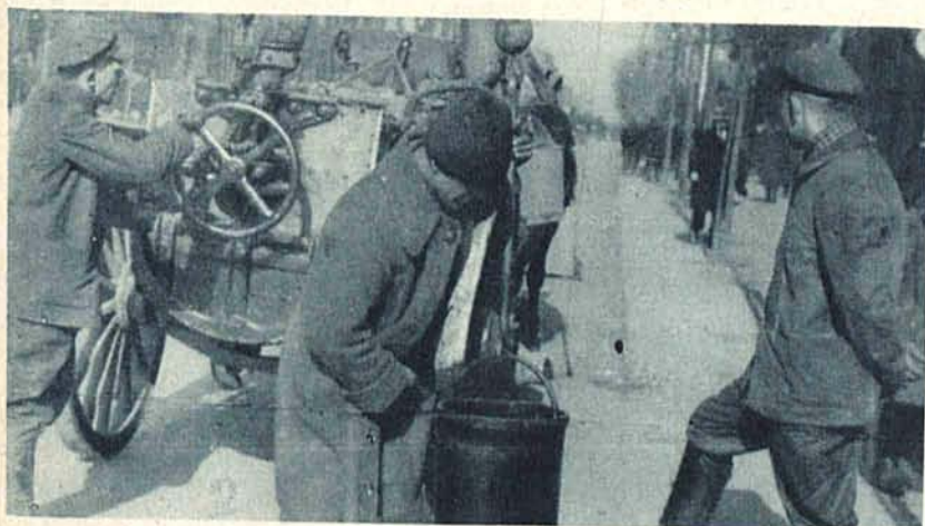
Czyszczenie rur kanalizacyjnych przy pomocy specjalnych maszyn.
