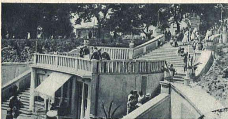
Schody na plażę.
