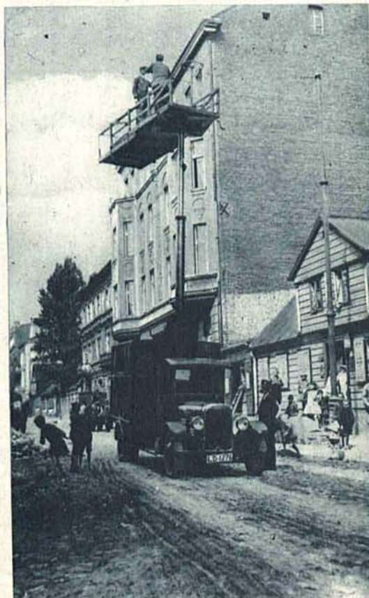
Zakładanie lamp elektrycznych przy ul. Wólbrońskiej przy pomocy nowego pomysłowego aparatu.
