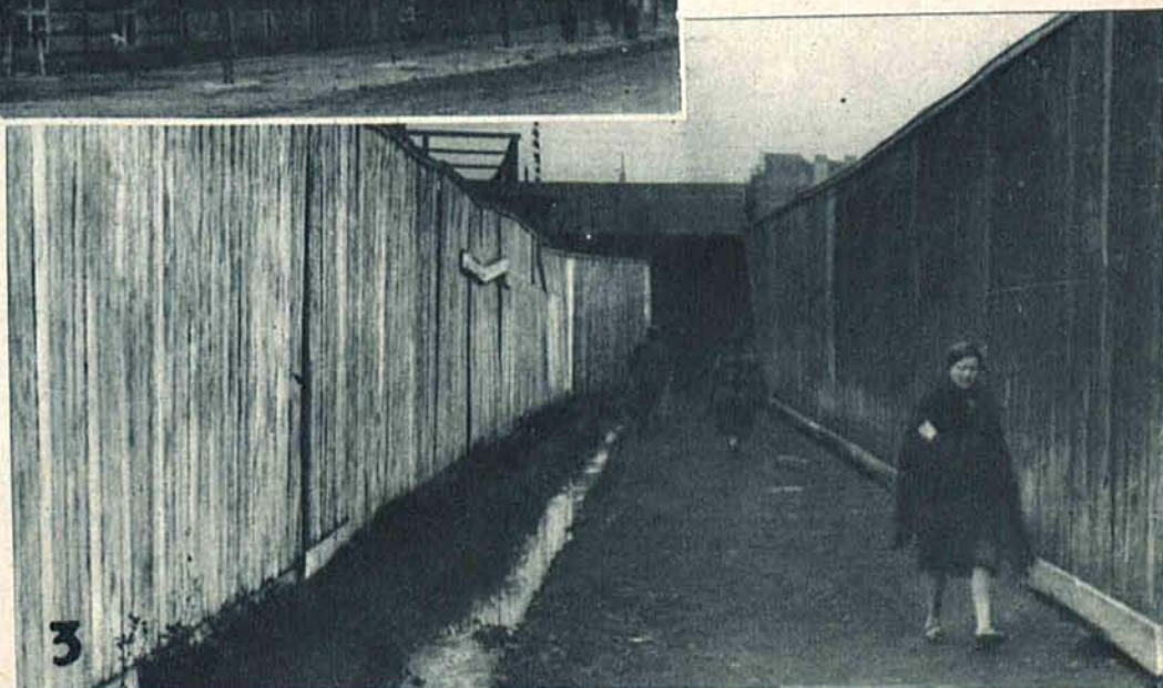
3. Wejście do tunelu przy ul. Zagajnikowej.
