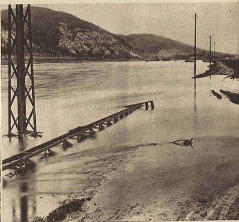
Powódź w Niemczech wyrządziła olbrzymie szkody; w dopływie rzeki Saal, woda zalała i zniszczyła tor kolejowy.
