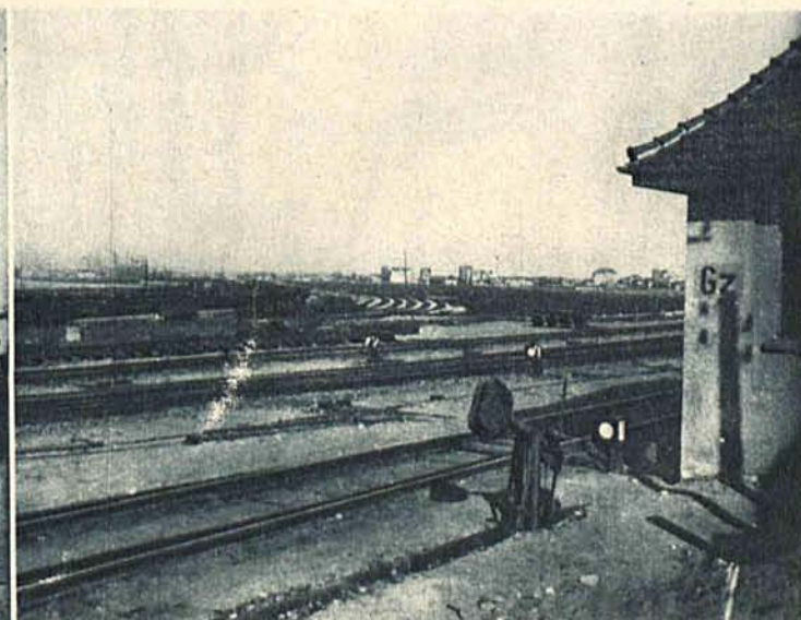
Dworzec portowy w Gdyni.
