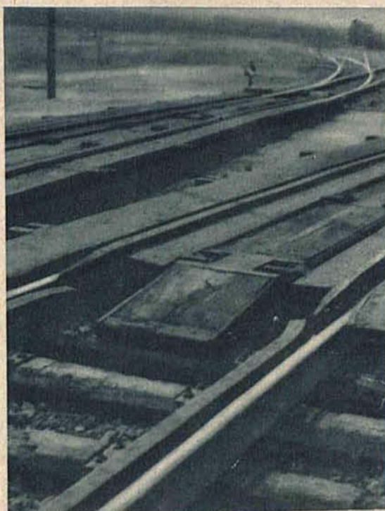
Hamulec automatyczny Fröhlicha zatrzymujący pociąg, wjeżdżające na fałszywy tor.
