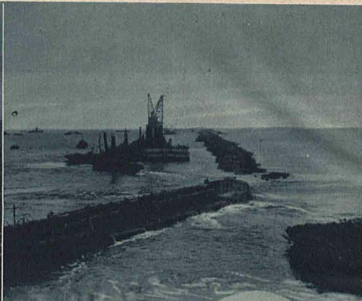
Od wielu lat pracuje rząd holenderski nad zasypaniem odcinka morza zwanego Zuidersee. Obecnie ukończono główny wał ziemny stanowiący tamę (na prawo). Na lewo widzimy jeden z olbrzymich kranów, syjących wciąż nowe masy ziemi w fale morskie.
