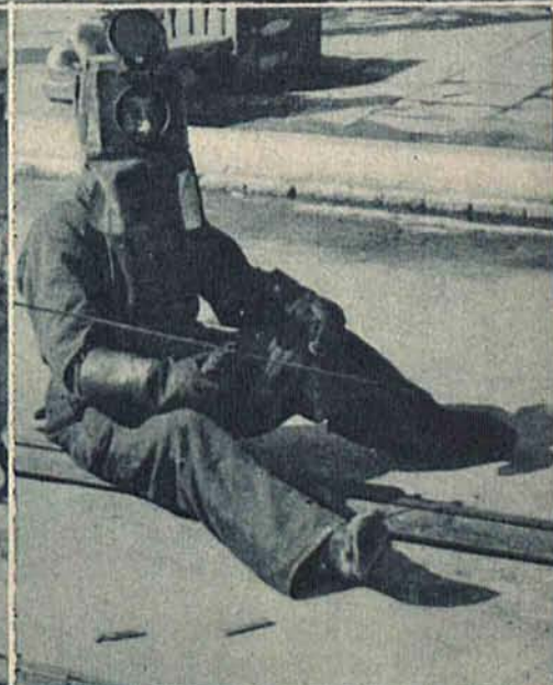
Montaż szyn tramwajowych na ul. Piotrkowskiej tam gdzie jest ona asfaltowana.
