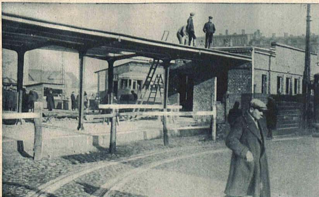
Budowa dworca tramwajowego na Placu Bałuckim, rażno postępuje naprzód.
