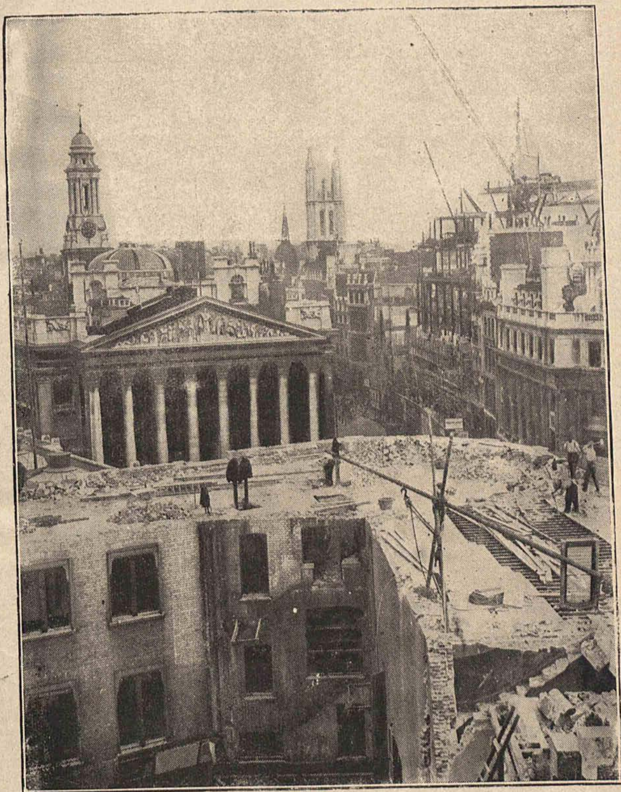
W Londynie cały szereg starych domów podlega w ostatnich czasach zburzeniu. Na naszej ilustracji widzimy pracę taką naprzeciw słynnego budynku, gdzie mie- ści się Bank of England.
