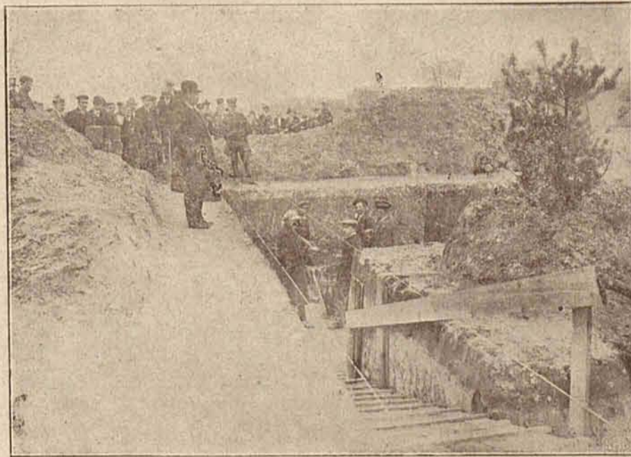
Budowa fundamentów już się rozpoczęła.
