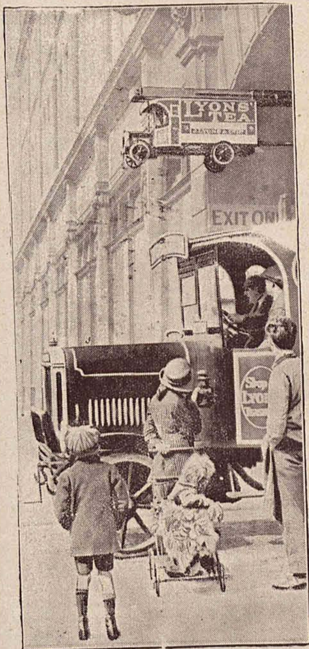
Nowy sygnał ostrzegawczy przed samochodami: na ulicach Londynu na skrzyżowaniach publiczność ostrzegana jest przez znak specjalny, a mian. małe auto, które na specjalnej szynie wysuwa się naprzód, gdy do rogu zbliża się samochód.
