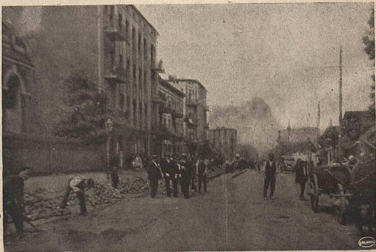
Z robót nad układaniem nowej linii tramwajowej na ul. Rzgowskiej (została ona już skończona).
