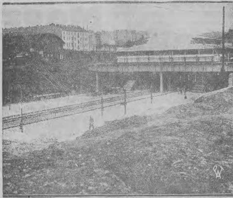
Widok na nowy tymczasowy dworzec średnicowy w Warszawie, po zburzeniu okalającego go płotu w Alei Jerozolimskiej. Widoczne są podjazdy po obu stronach odkrytego tunelu oraz perony betonowe.
