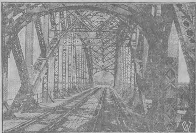
Most na Wiśle, zbudowany specjalnie dla warszawskiej linii średnicowej, której uroczyste otwarcie nastąpi dnia 2 września. Do budowy tego mostu zużyto 5000 ton żelaza. Powierzchnia muru wynosi 22.000 m 2 .
