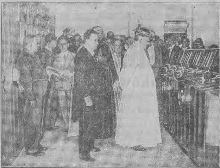
Watykan zaopatrzone został w nową instalację ogrzewalną, wyposażoną w najnowsze urządzenia techniczne. Na zdjęciu Ojciec Św. ogląda urządzenia centralne.
