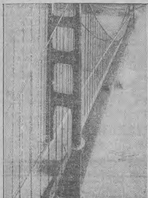
Rząd amerykański przystępuje do budowy mostu „Golden - Gate”, który połączy San Francisco z Oaklandem. — Koszt budowy wyniesie 75 mili. dolarów.
