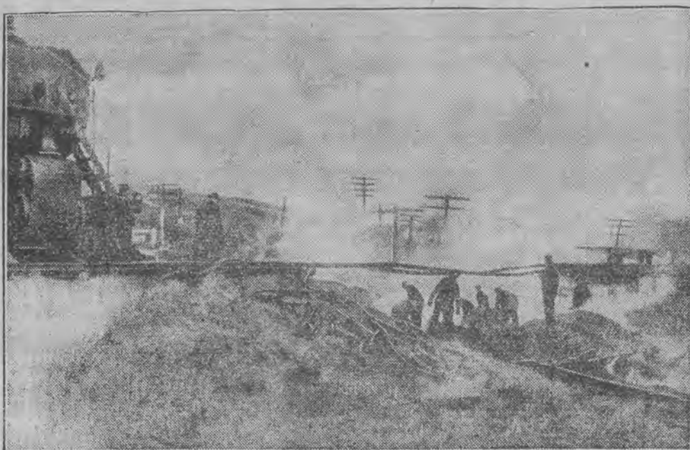
Podczas strajku farmerów amerykańskich doszło w szeregu wypadków do poważnych uszkodzeń linii kolejowych. Zdjęcie przedstawia zniszczony tor w pobliżu City (Jowa USA).
