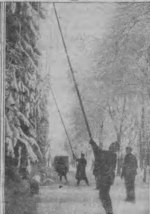
Druty telegraficzne, grubo pokryte śniegiem i zlodowaciałe (z lewej), nie mogą spełniać należycie swej roli. Specjalne brygady zmagają się wobec tego ich oczyszczeniem.
