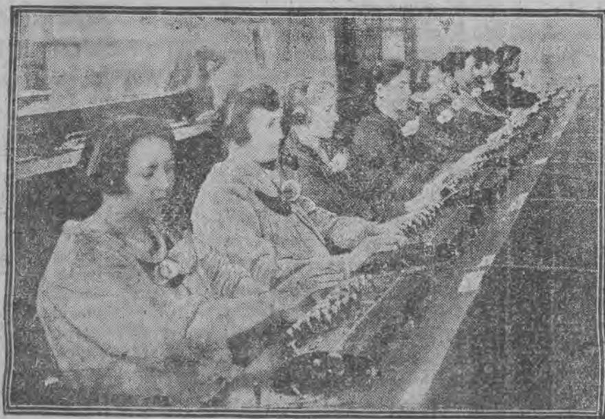
Dawniej telefonistki łączyły zapomocą zatyczek, obecnie wprowadzono automaty elektryczne, które pozwalają szybko i sprawnie łączyć abonentów.
