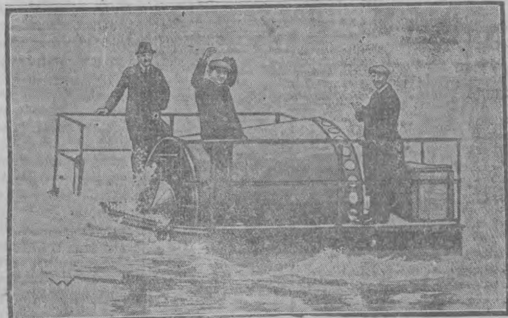
Inżynier Ed. Suess wynalazł turbinę wodną, która po zanurzeniu w wodzie bieżącej, poruszana siłą prądu wytwarza prąd elektryczny
