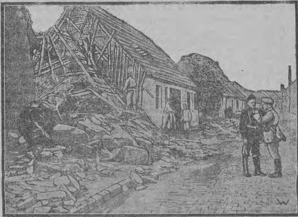
Oberwanie się chmury miało miejsce pod Magdeburgiem w środkowych Niemczech. Ilustracja nasza przedstawia ulicę jednego z miasteczek, zniszczonego i zatopionego przez nawałnicę
