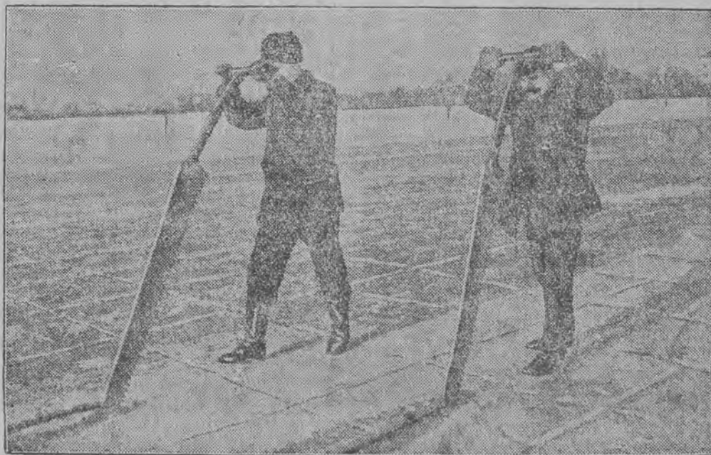
Rycina powyższa przedstawia technicznie udoskonaloną eksploatację lodu. Pługiem lodowym specjalnej konstrukcji dzieli się pole lodowe na prostokątne części, poczem przecina się je wielkimi piłami dla umożliwienia transportu
