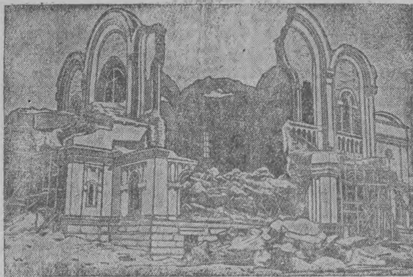
Burzenie soboru na pl. Saskim w Warszawie
