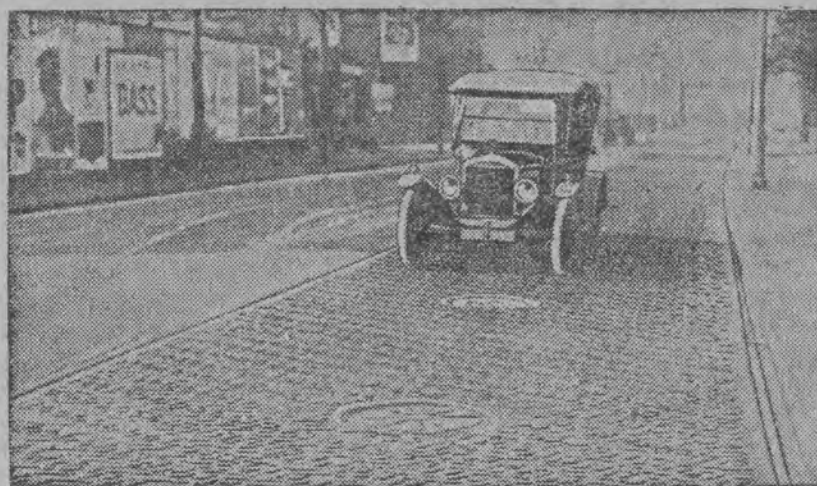
W Acton pod Londynem dokonano próby wybudowania szosy z gumy. Jest ona wybudowana z kostki drewnianej, pokrytej warstwą gumy. Jak dotychczas droga ta okazała się bardzo praktyczną.
