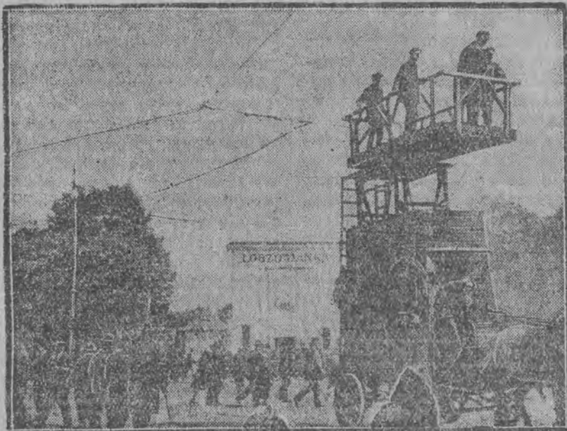
Naprawianie przewodników tramwajowych w Warszawie
