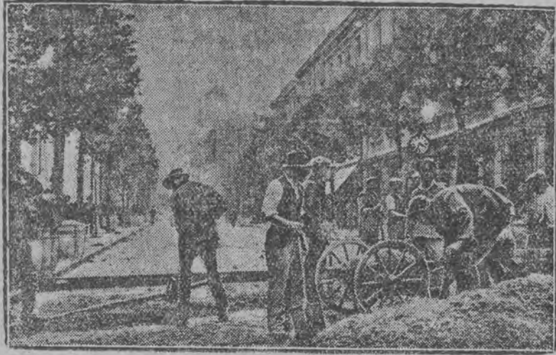
Ulica Traugutta otrzyma niebawem jezdnię asfaltową.
