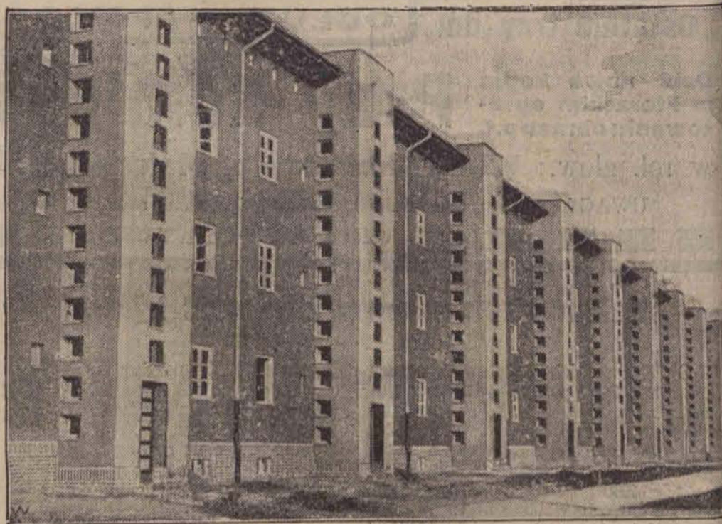
Niemcy mają obecnie nadmiar pieniędzy, które zużytkowują na wzmocnienie ruc budowlanego. Pod Berlinem powstają całe kolonie domów robotniczych, z których jeden szereg przedstawia powyższa rycina.
