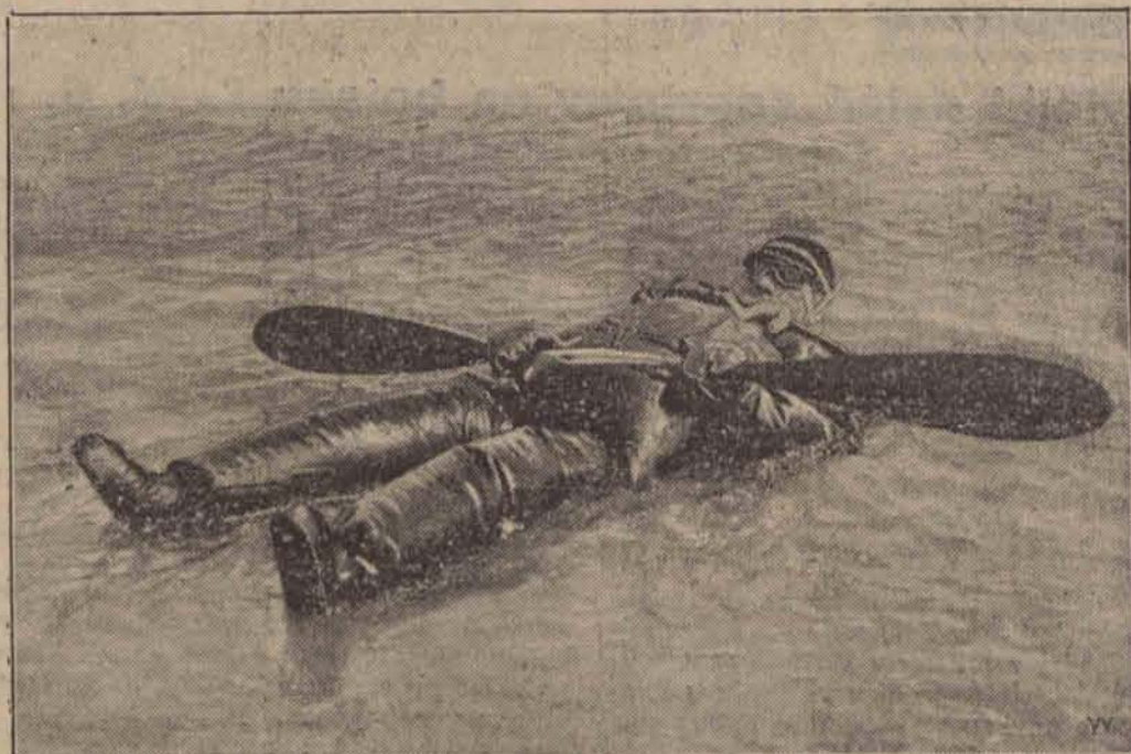
Amerykański wynalazca skonstruował specjalny ubiór gumowy, który pozwala rozbitkowi w wygodnej pozycji leżącej przepływać znaczne przestrzenie w wodzie przy pomocy małych wiosłek.
