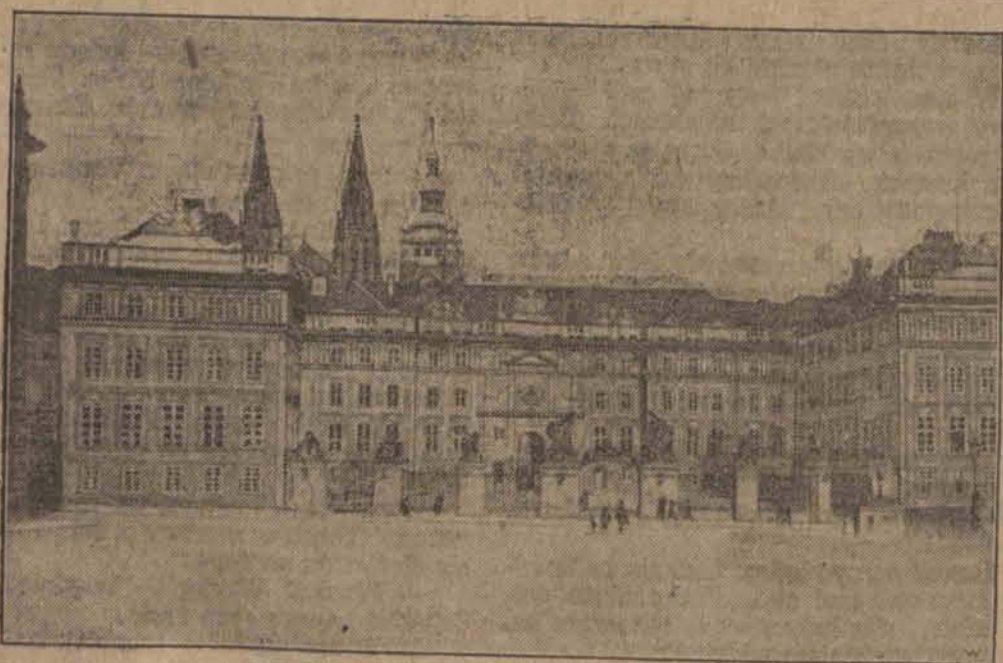
Słynny zamek królewski na Hradczynie w Pradze Czeskiej zaczął się w kilku miejscach gwałtownie rysować i komisja rzeczoznawców stwierdziła, że zachodzi niebezpieczeństwo zawalenia się. Gabinet ministrów wyasygnował 10 milionów koron na natychmiastowe wszczęcie robót konserwacyjnych.
