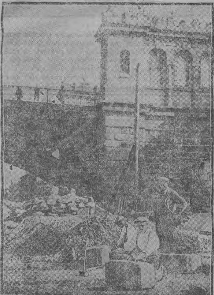
Ociosywanie głazów granitowych pod pierwszy filar drugiej połowy mostu Poniatowskiego.
