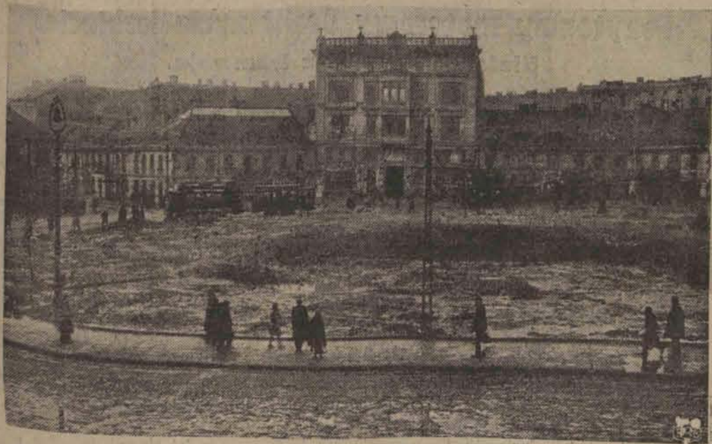
Obecny wygląd Placu Wolności po przeprowadzeniu robót kanalizacyjnych mających odwozić fundamenty przyszłego pomnika Kościuszki.
