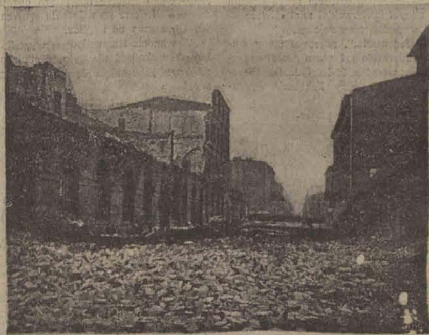
Po lewej stronie resztki murów trzypiętrowego gmachu, którego przednia ściana runęła na jezdnię, niszcząc naprzeciw leżący domek drewniany. Fot. Aleksander Meyer.
