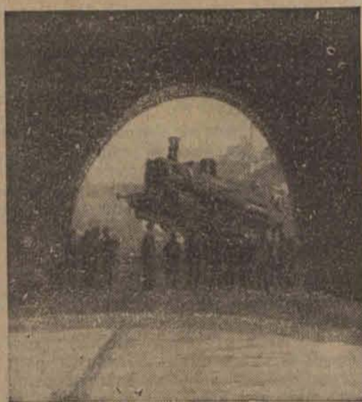
W Elberfeld spada z nasypu lokomotywa i zatrzymała się na węglarce.
