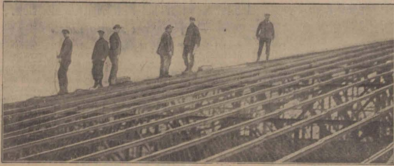
Naprawa oszklonego dachu Muzeum Brytyjskiego zniszczonego orkanem jaki przed kilku dniami nawiedził Anglię.
