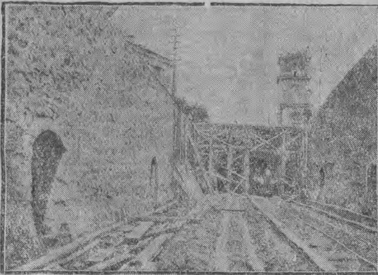
Wywożenie ziemi z tunelu wagonetkami.
