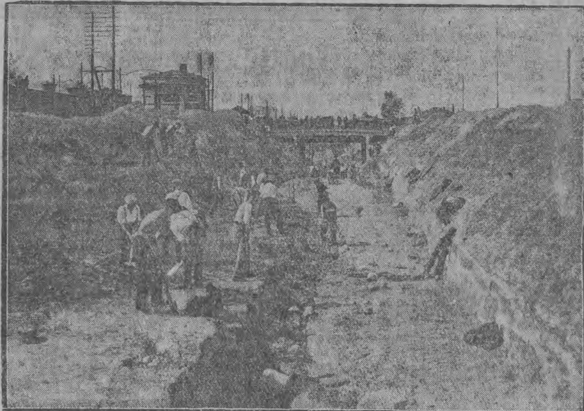
Wykop przy ul. Towarowej.
