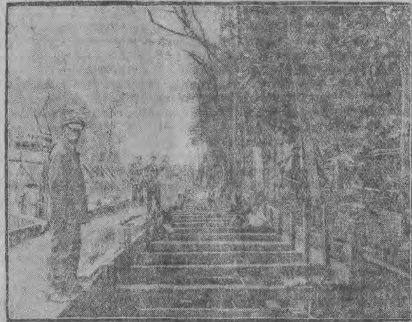
Wykop w Alejach Jerozolimskich
